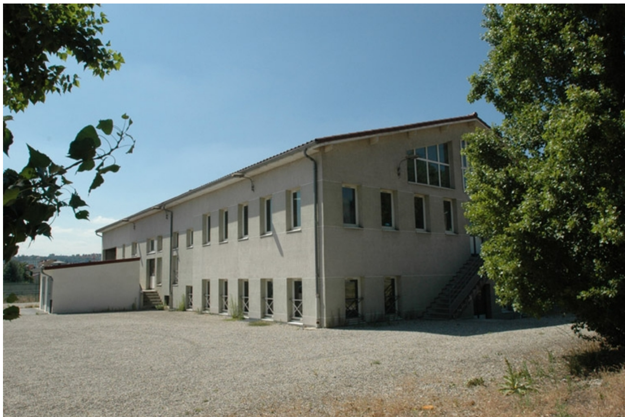
Vue du bâtiment n° 7
