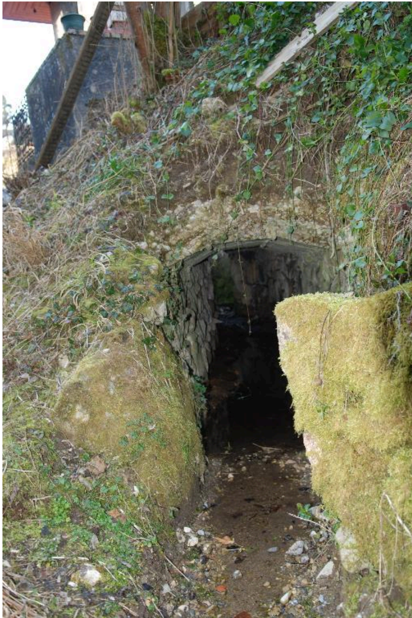
Conduit d'échappée de l'eau du moulin aval, extrémité avale.
