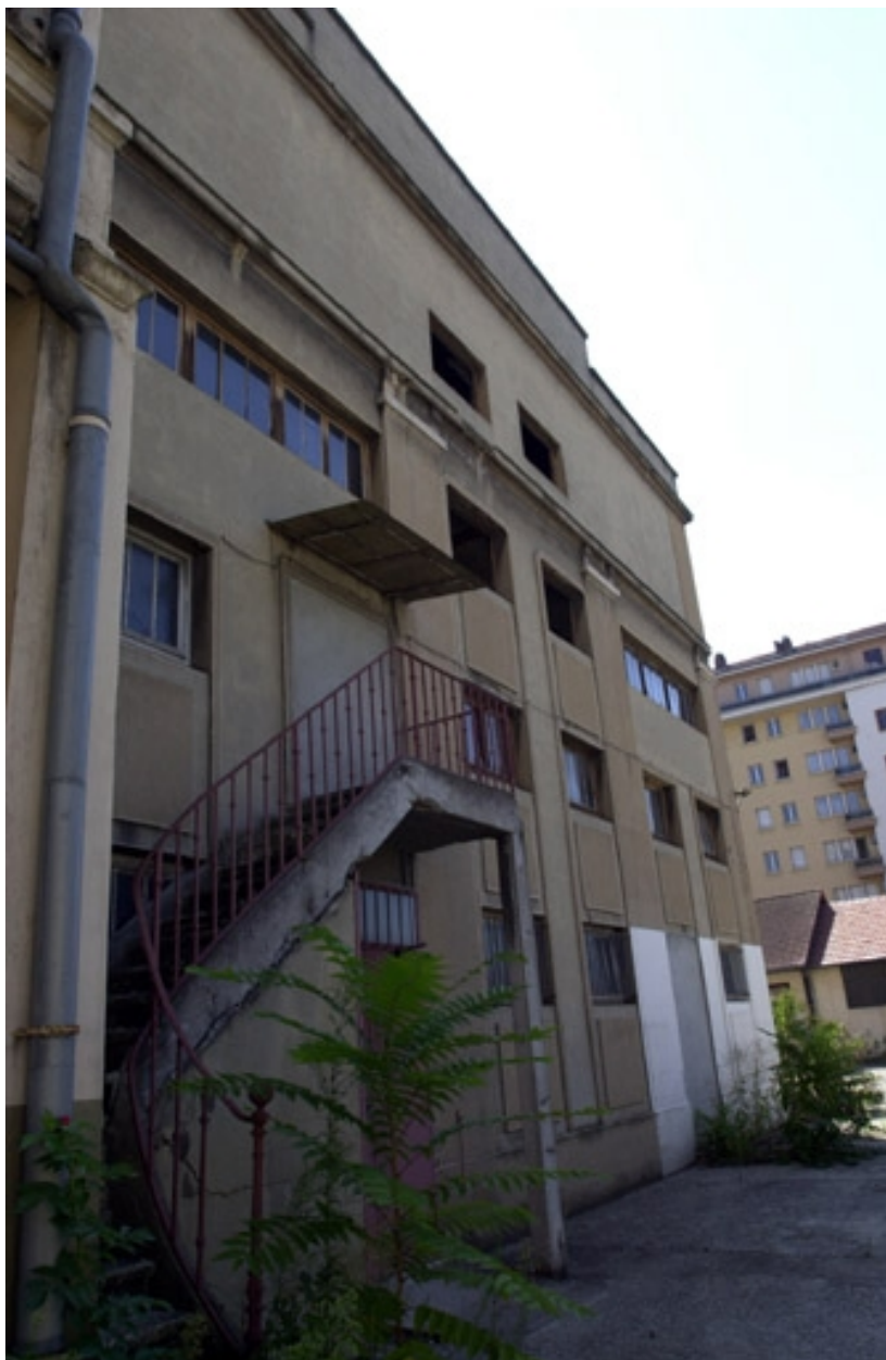
Vue nord du bâtiment des années 30
