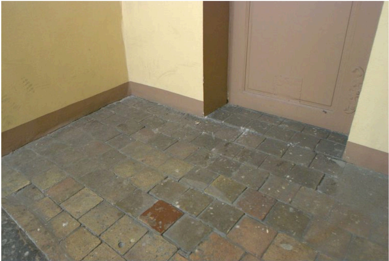
Le palier en carreaux de terre cuite du 1er étage
