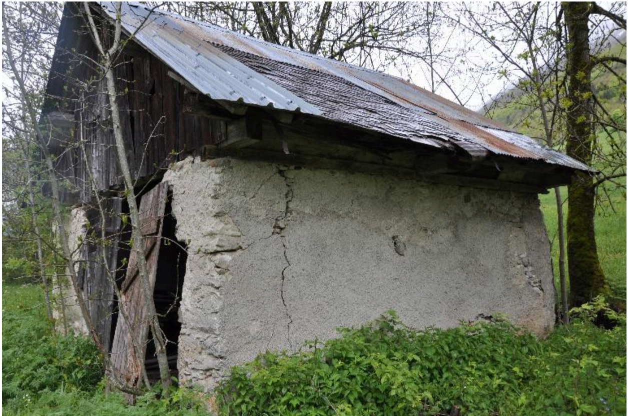
Façade sud du moulin.
