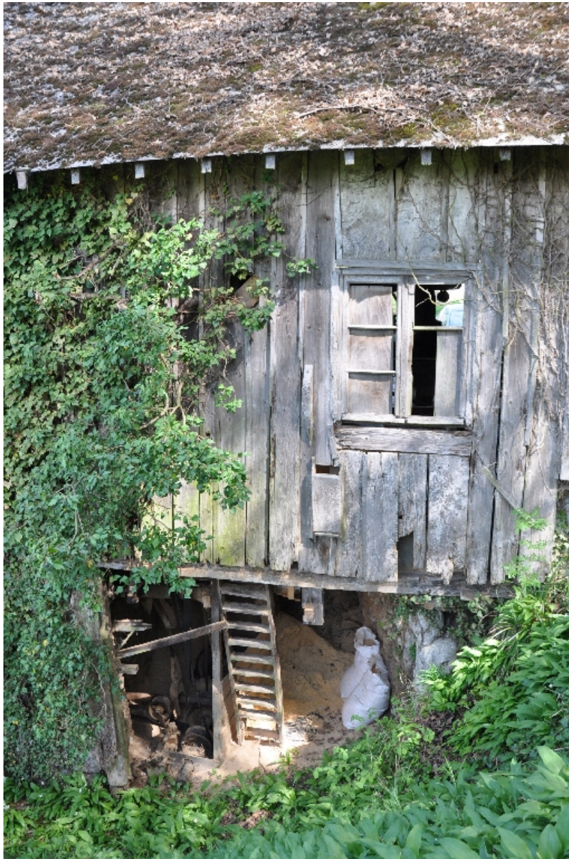
Détail de la façade sud
