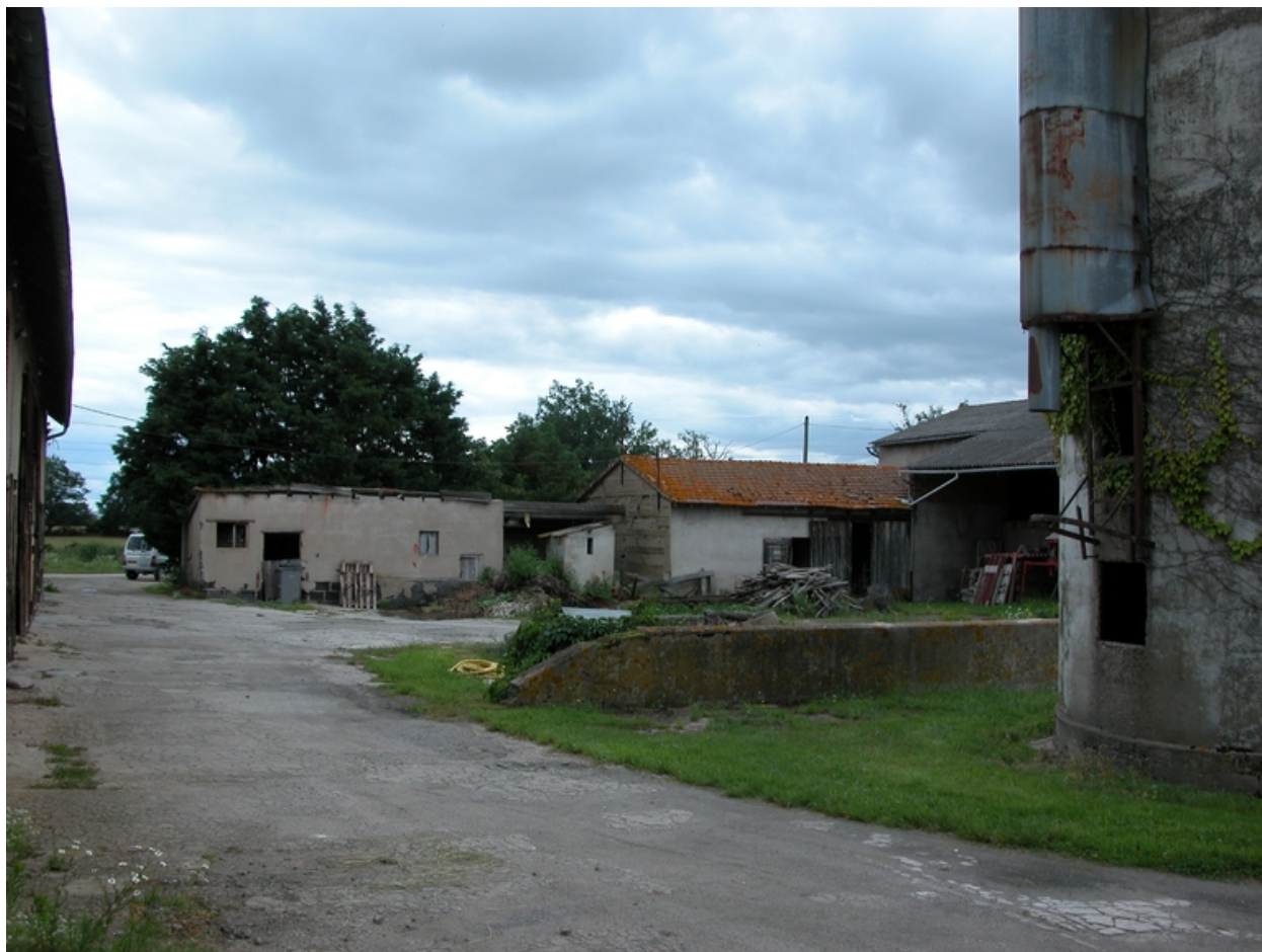
Vue du côté est de la cour.
