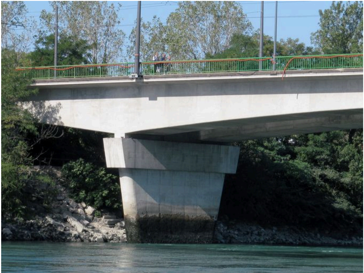
Pile, face amont (depuis la rive droite)
