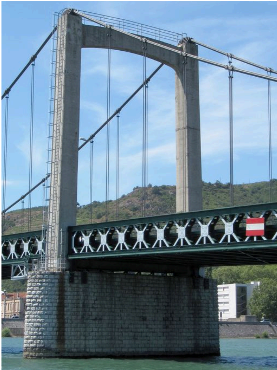
Pylône central (depuis la rive droite)
