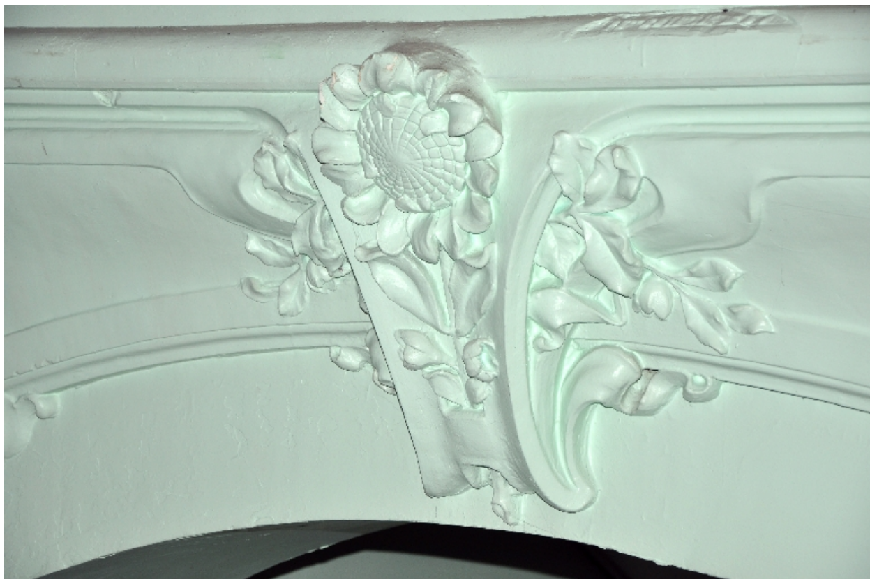
Corps principal, atrium : décor de stuc
