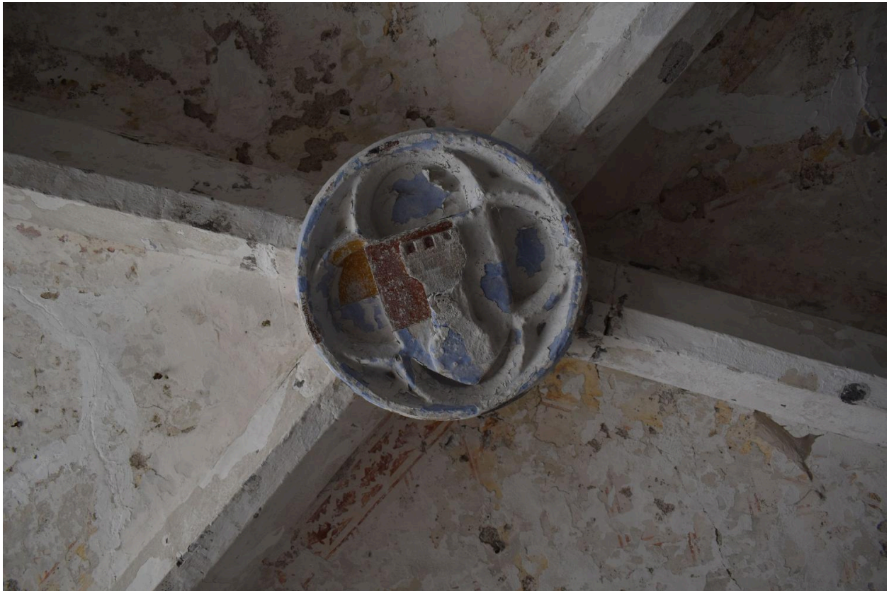
Clef de voûte armoriée et vestige de décor peint de l'église, 3e travée.
