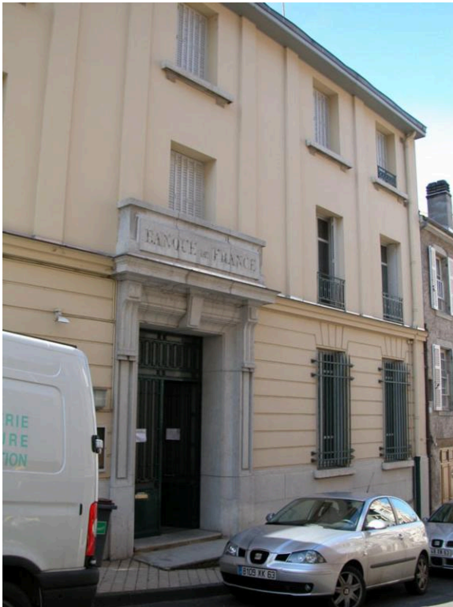
Elévation nord-est, sur la rue de Barante : accès principal à la banque pour le public. (photographie chercheur).
