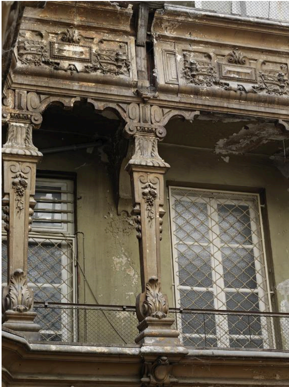
Cour, balustres portant la galerie du 2e niveau
