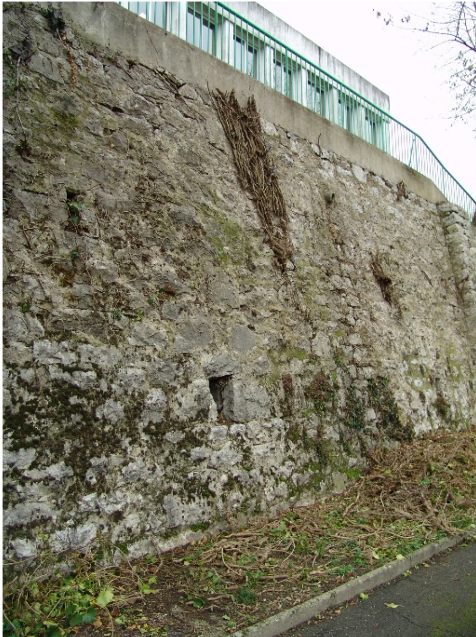
Bâtiment de 1962 : mur de soutènement
