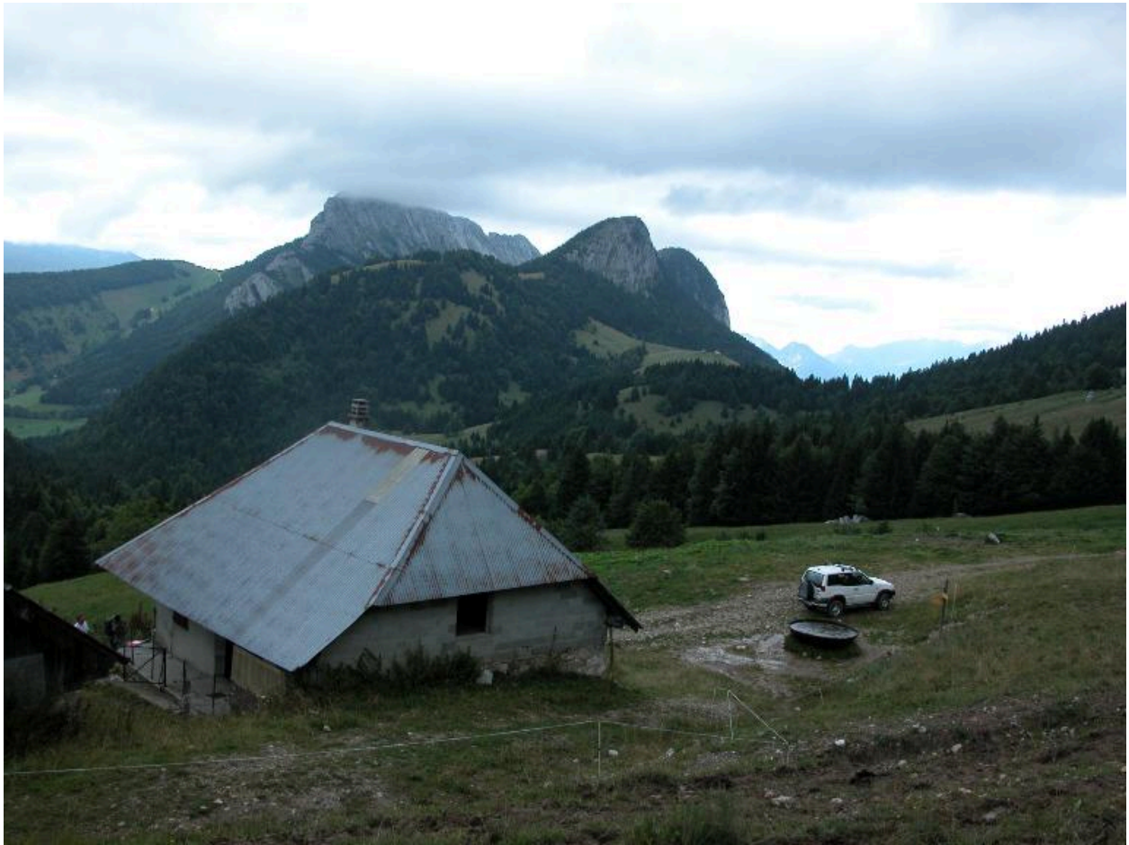
Vue de la façade nord du bâtiment d'habitation.
