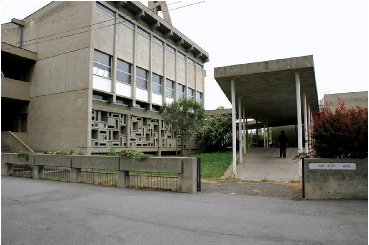
Entrée de la cité paroissiale, avenue Viviani
