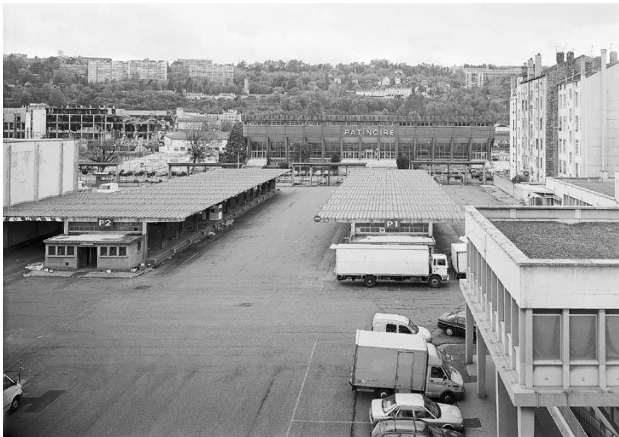
Partie nord-ouest du marché depuis le toit-terrasse du bâtiment administratif. A gauche, la halle de pesage
