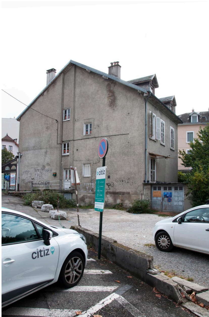
Façade postérieure, vue de trois-quart depuis le sud-ouest
