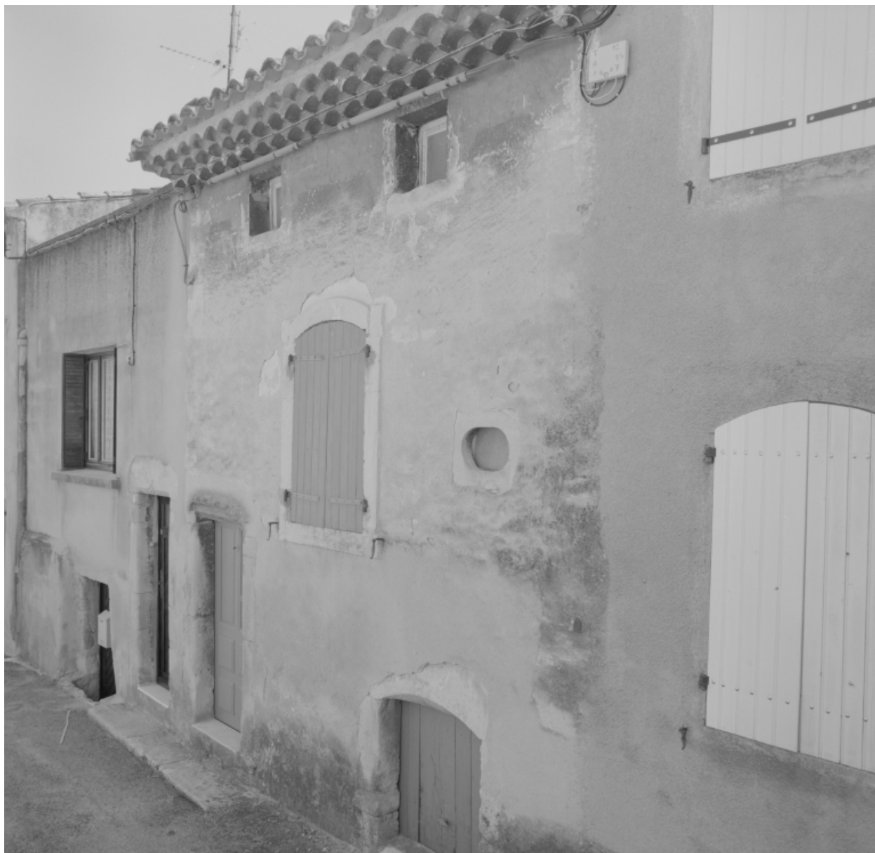
Maison (A 575), 9 Grande rue. Vue d'ensemble de la façade.
