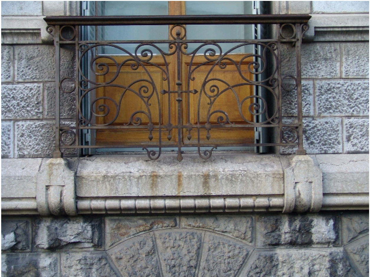
Détail du bandeau à hauteur d'une baie
