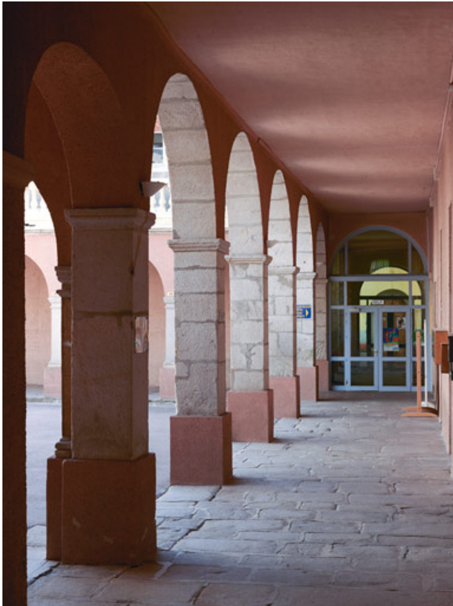
Galerie longeant le bâtiment A depuis l'entrée de la chapelle.
