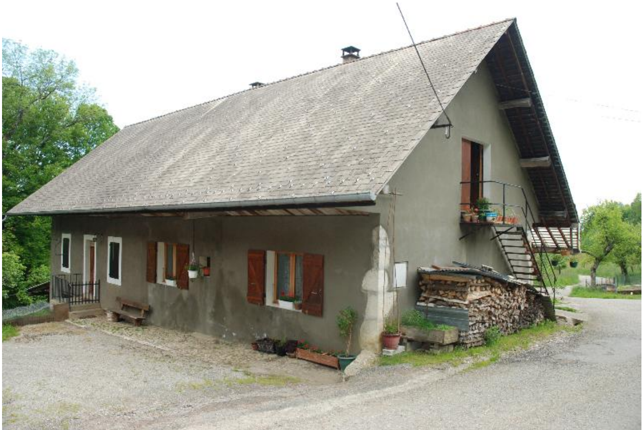
Ferme non repérée (2013 B4 401), façade principale.
