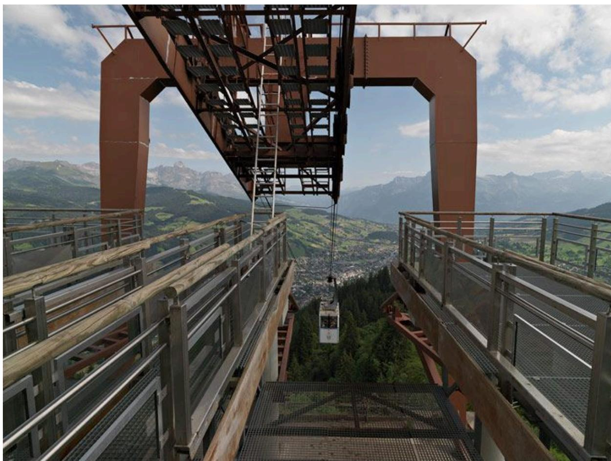
Gare supérieure. Portique et rails de portage des câbles. La cabine en montée
