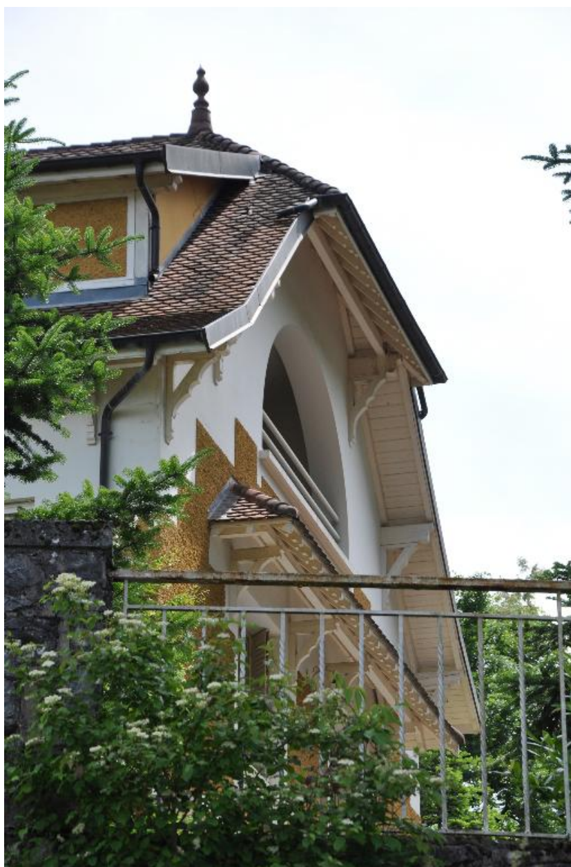
Balcon loggia sur le pignon sud
