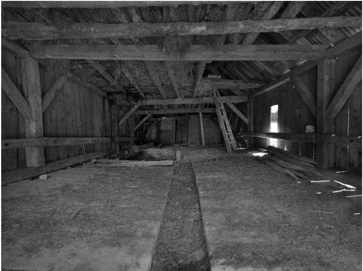
Vue intérieure de l'étable, depuis le sud.
