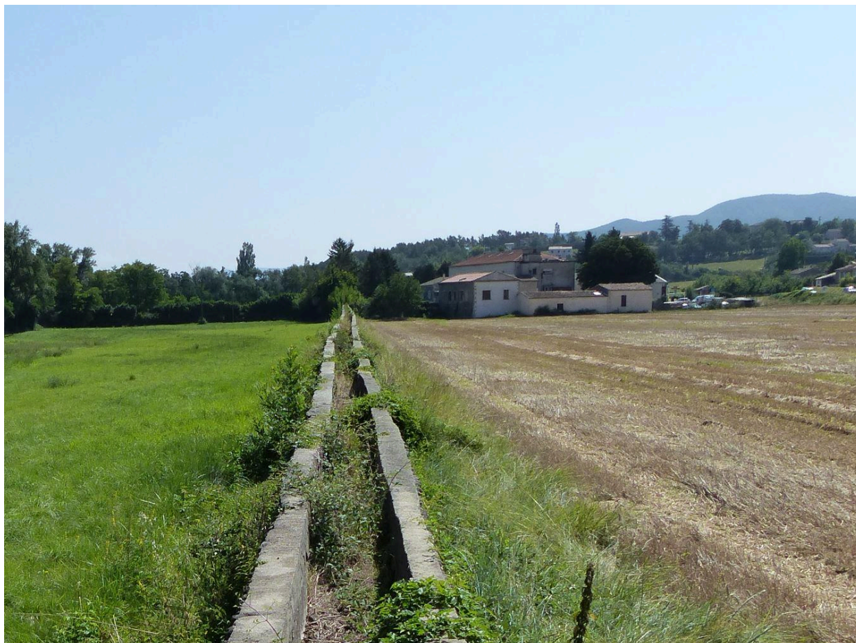
Aqueduc vue du canal par en-dessus, moulinage de la Neuve à Chomérac
