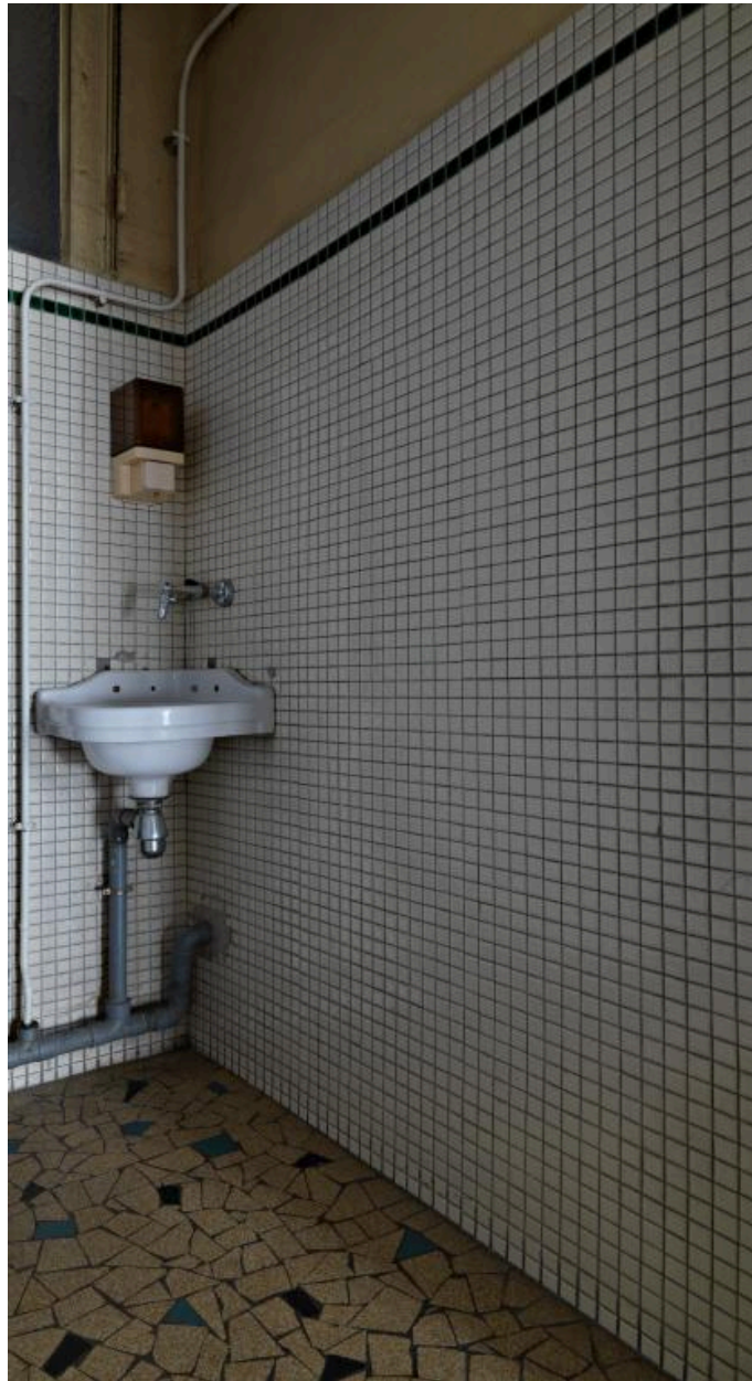
Salle Rameau : au niveau du premier balcon, toilettes
