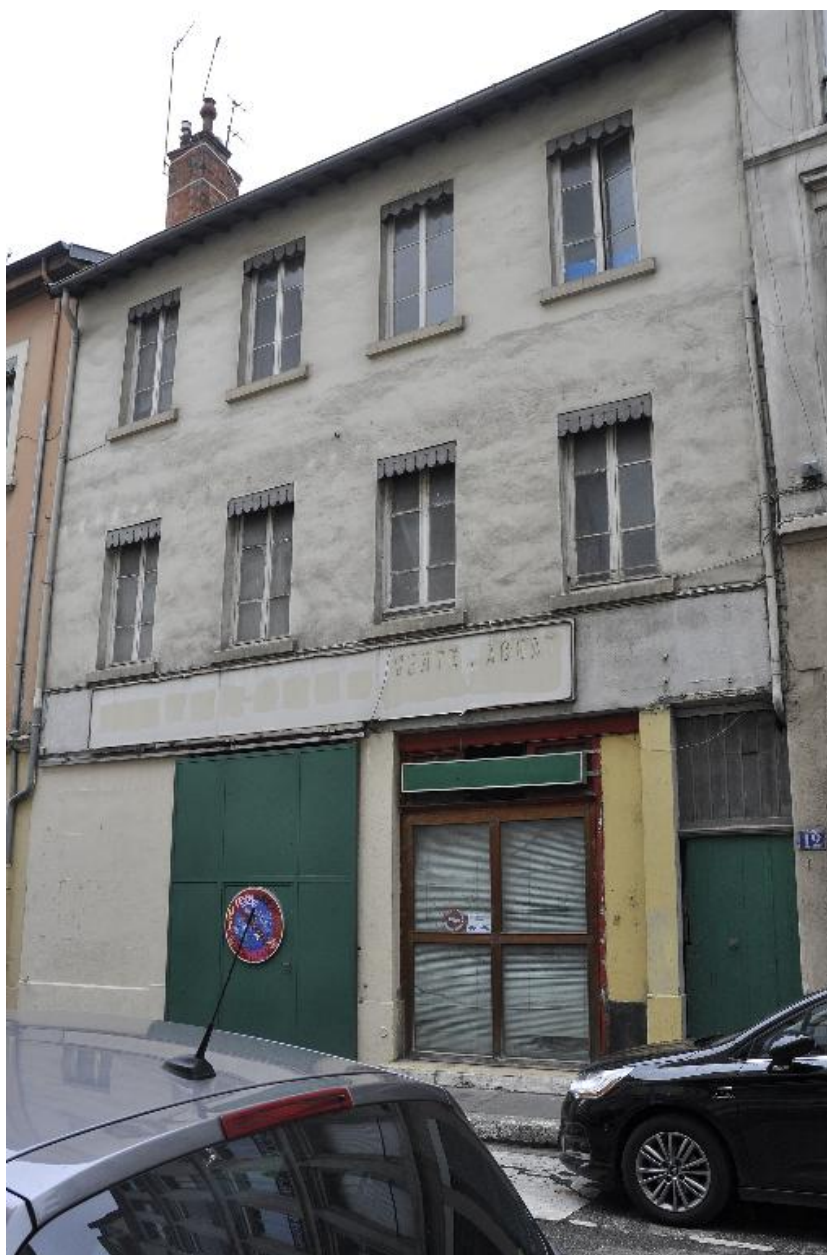
Vue générale de l'élévation sur rue
