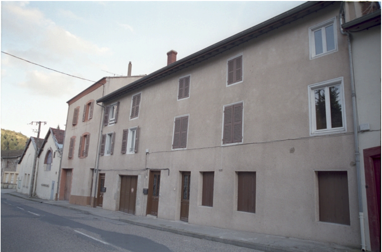
La Font Fort, maison à encadrement de bois vue depuis la route (1986 C2 688).
