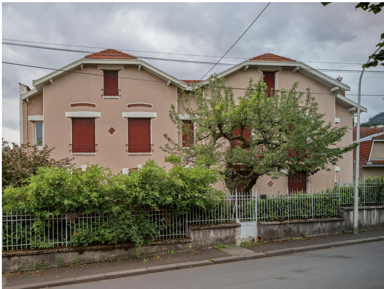
Vue de la Villa Mon Désir, depuis l'avenue Beausite
