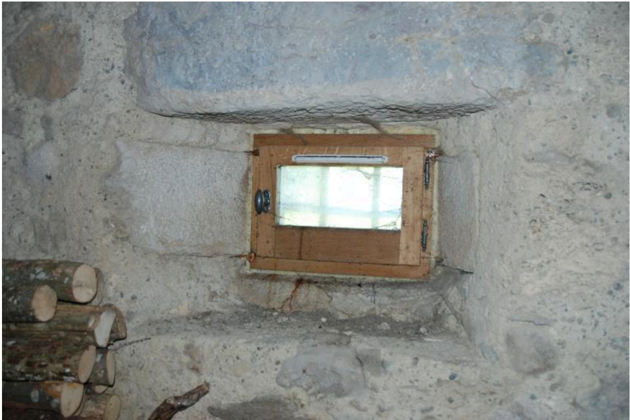
Rez-de-chaussée. Intérieur de la cave 1, soupirail situé dans le mur sud.
