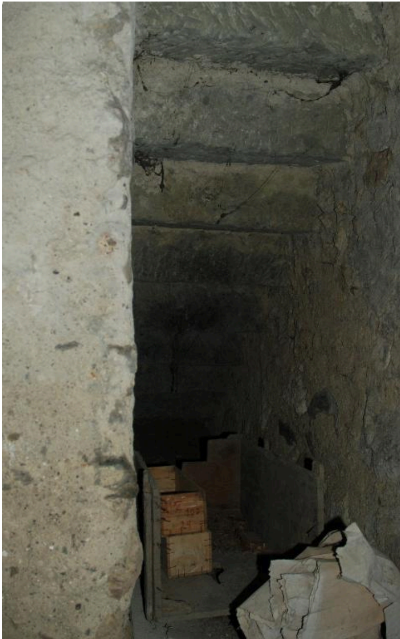
Vue du dessous de l'escalier.
