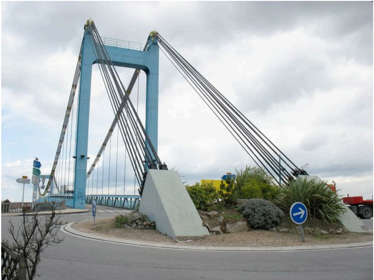
Rive droite : pylône, câbles et massifs d'ancrage
