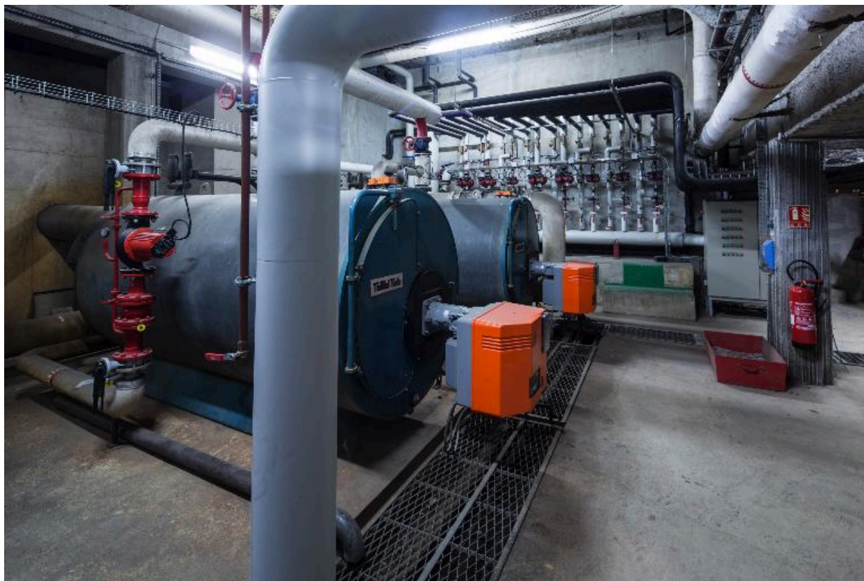
Bâtiment sud : chaufferie
