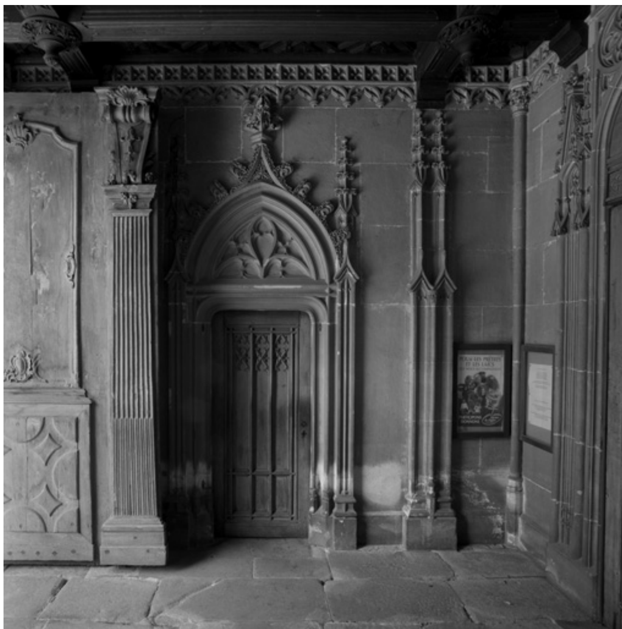
Vue d'ensemble de la porte latérale nord.
