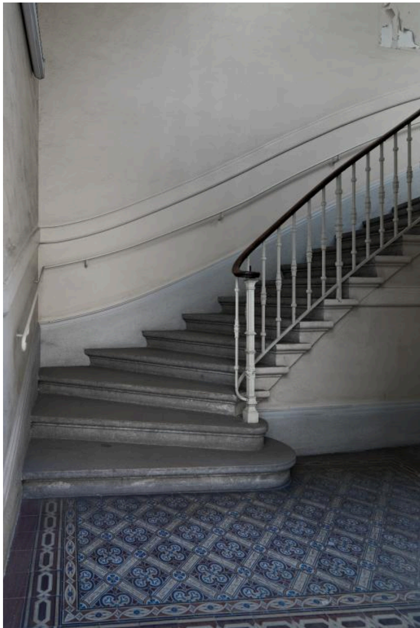
Salle Rameau : escalier secondaire ouvrant sur la rue Louis-Vitet (escalier C), départ
