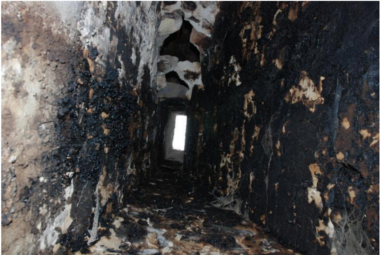
Vue intérieure du conduit de cheminée.
