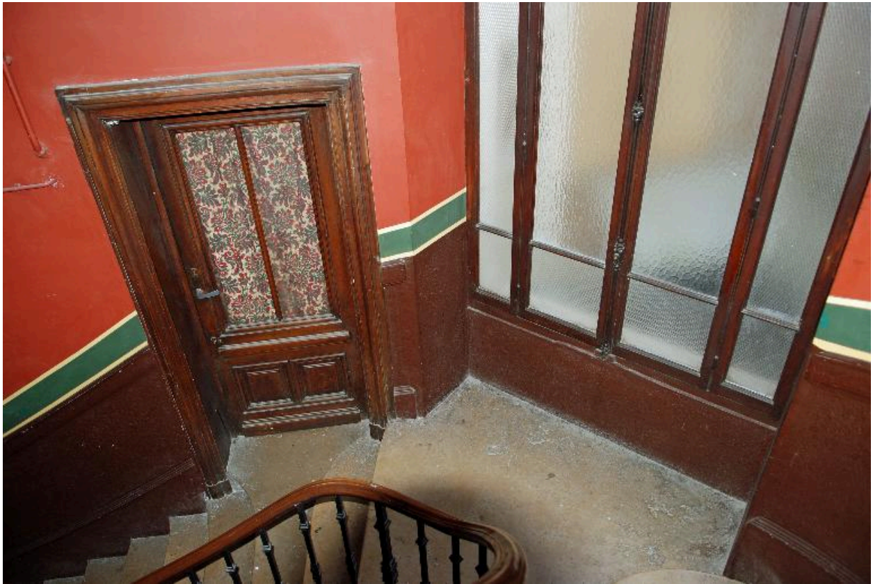
Vue intérieure : porte de la loge de concierge sur le premier repos
