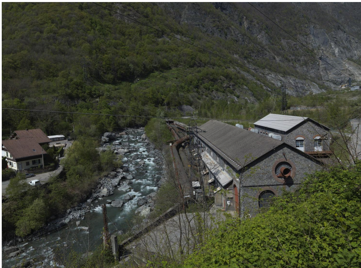
Vue du bâtiment et des conduites forcées
