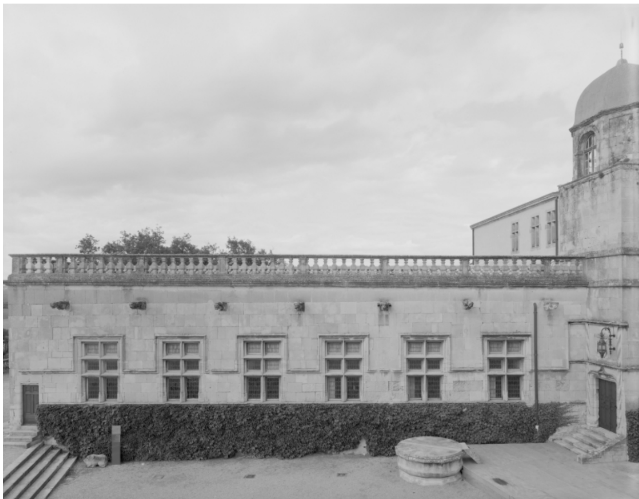
Cour du puits. Galerie. Vue générale.
