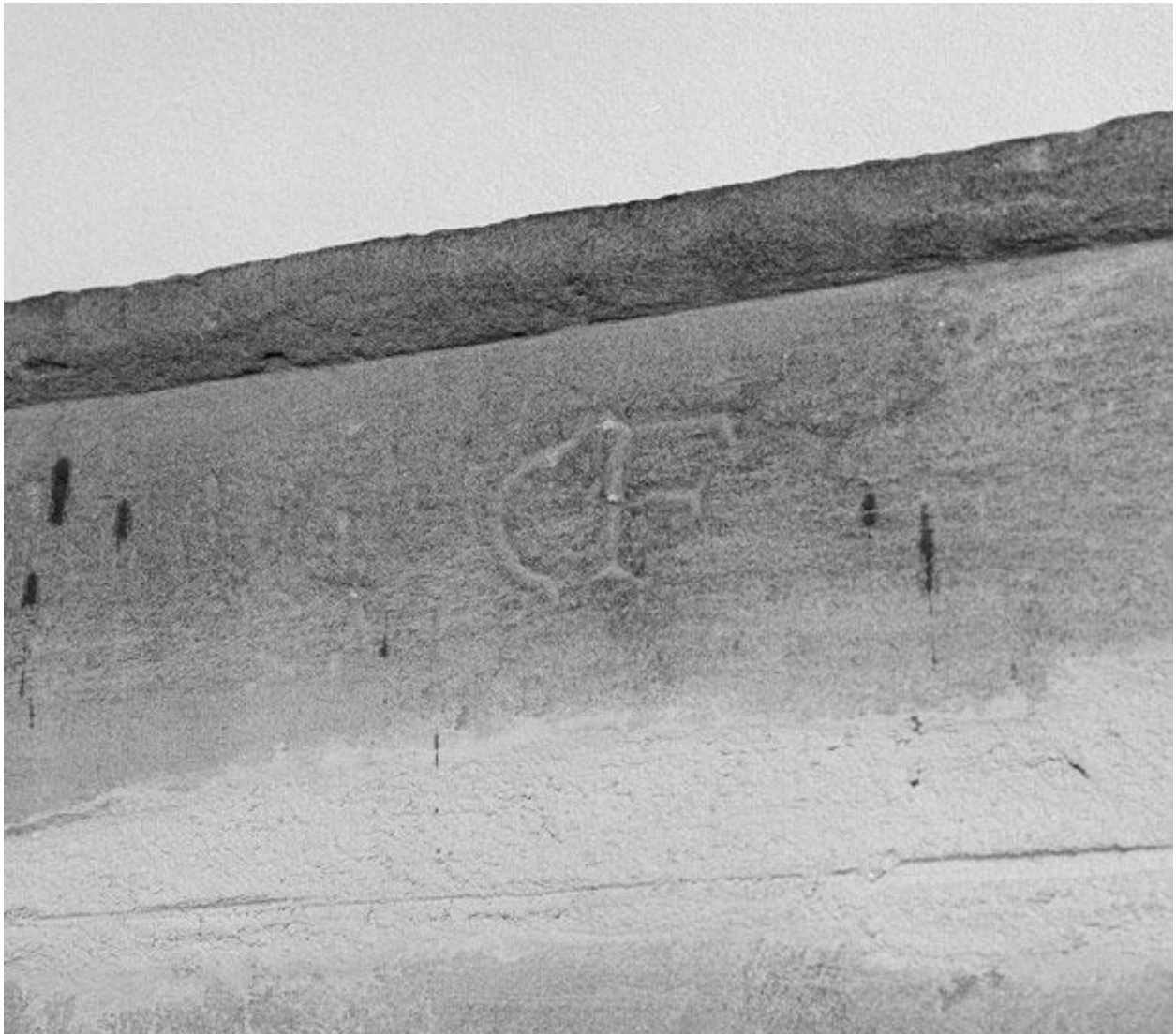
Détail de la marque de tâcheron, côté gauche du manteau de la cheminée
