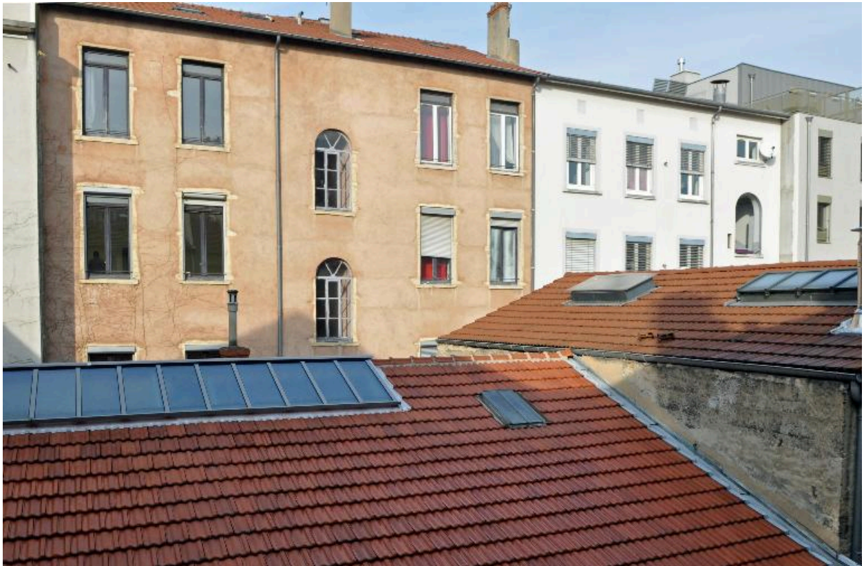
Elévation sur cour, vue partielle
