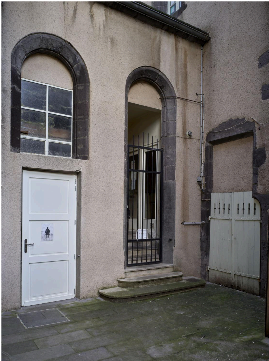
Cour : baies de l'ancienne sacristie de la chapelle Saint-Pierre (?), remaniées
