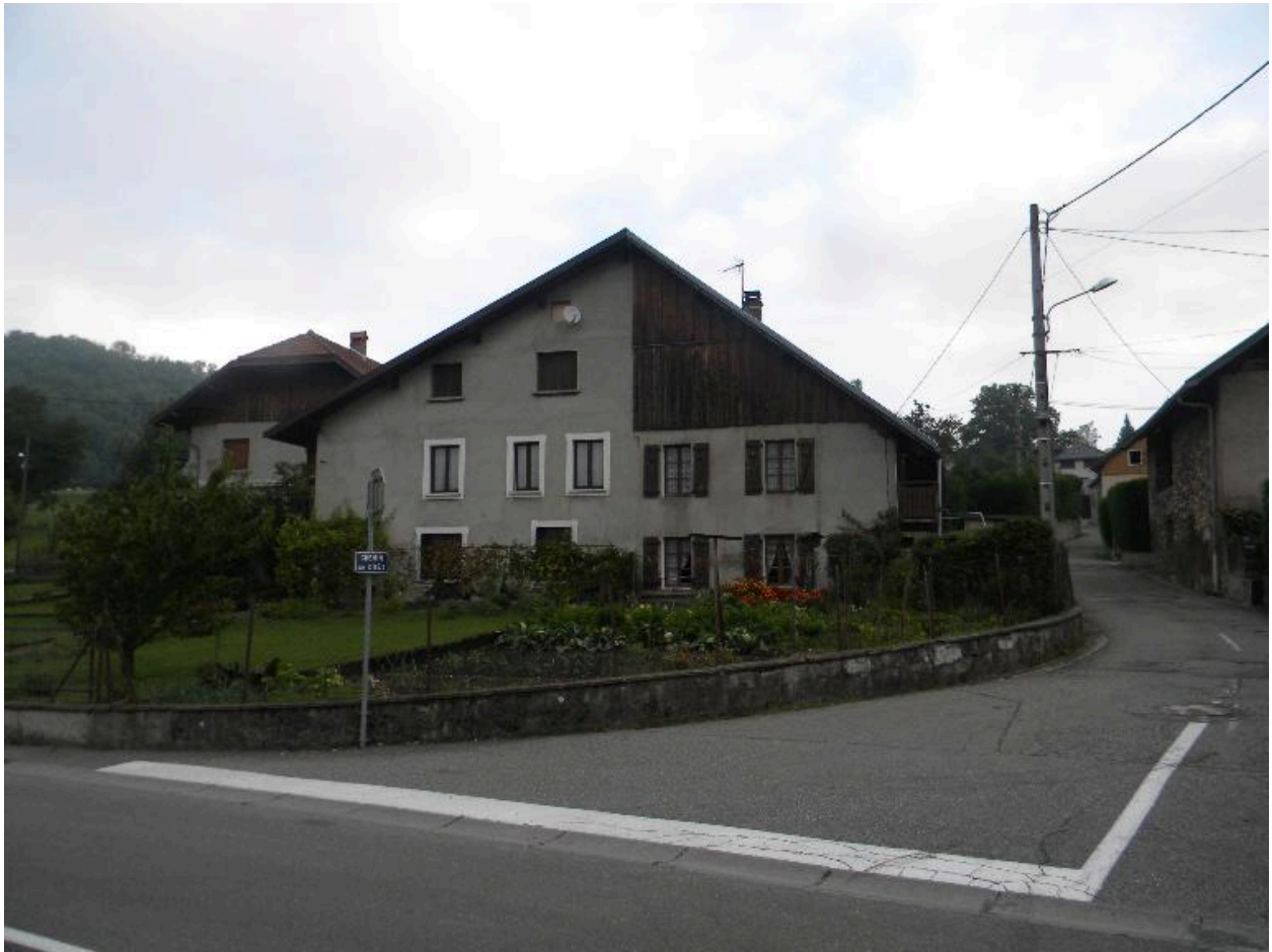
Vue du pignon d'une ferme double transformée (2008 E10 1449, 1677)
