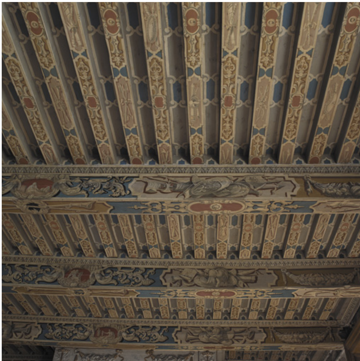
Vue intérieure, 1er étage : vue du plafond de la grande salle (depuis l'est).
