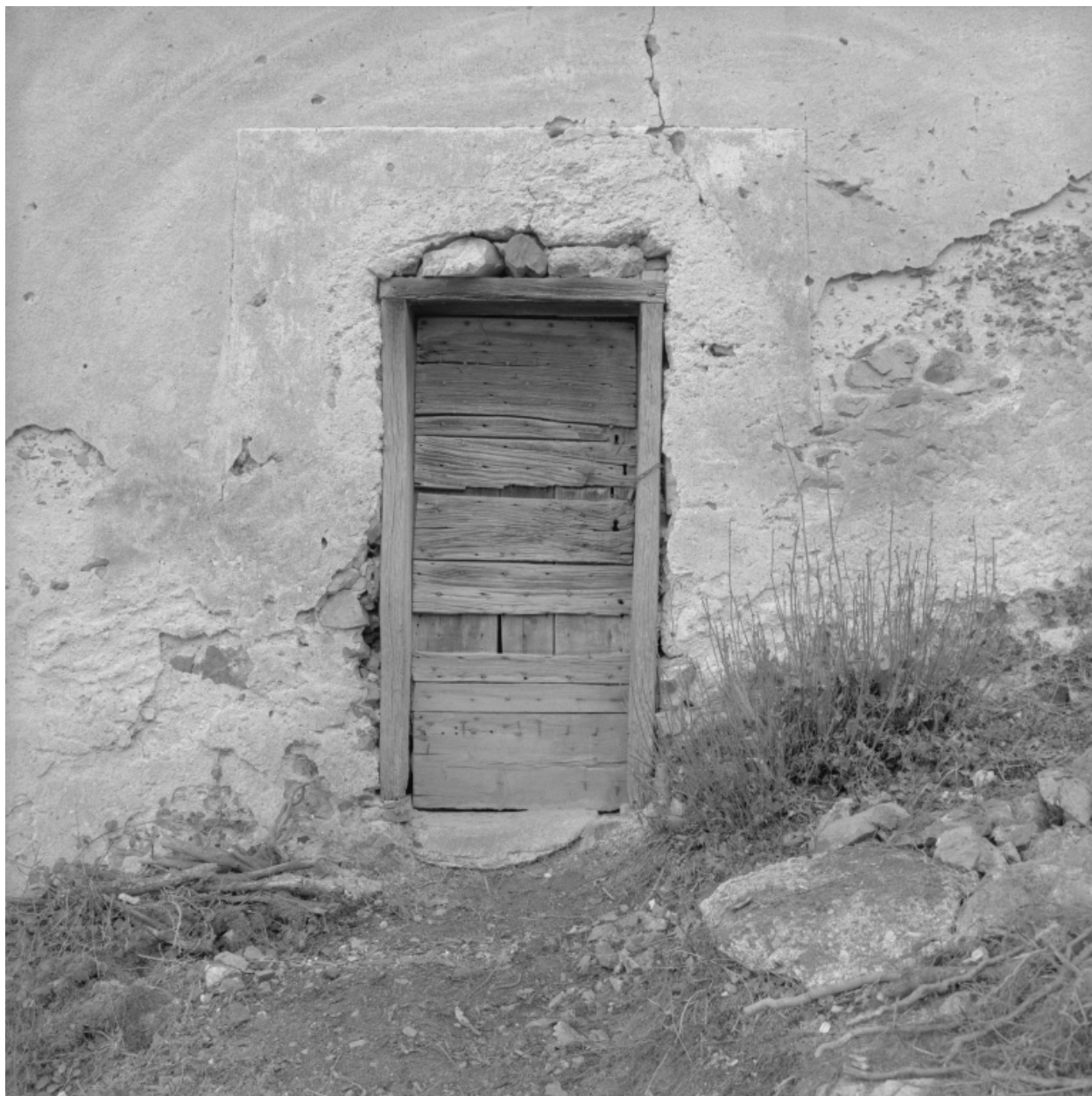
Détail de la porte d'entrée.
