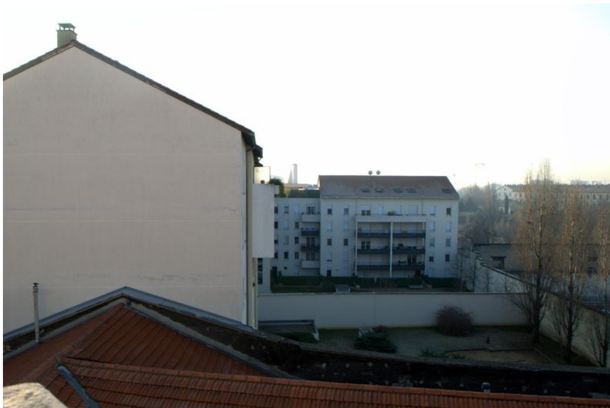
Elévation latérale postérieure, vue partielle depuis l'ouest
