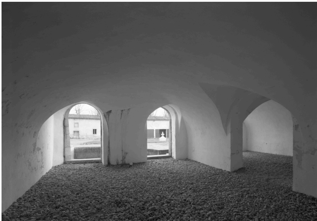
Etage de soubassement : vue intérieure générale, de l'ouest.
