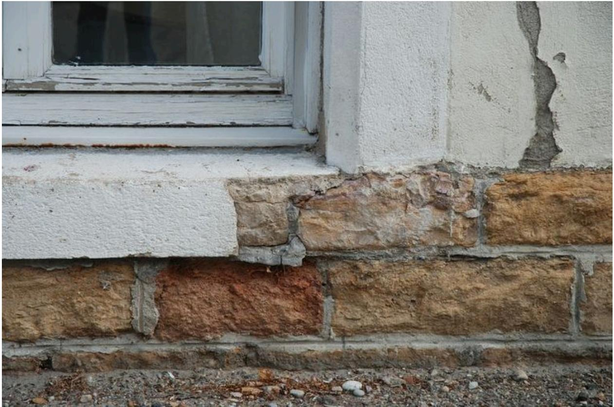
Façade latérale sud, détail de l'appareillage des moellons piqués
