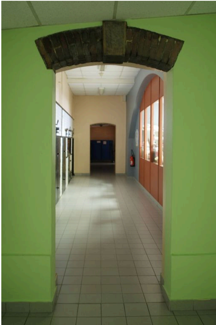
Ancienne boulangerie, vestiges d'une porte extérieure menant au four, arc segmentaire, briques et clé en pierre
